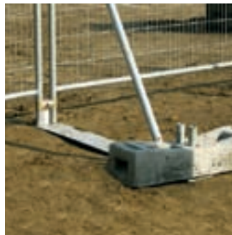
Płyta stalowa stabilizująca
