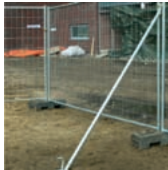
Wspornik. Zapewnia dodatkową stabilizację
