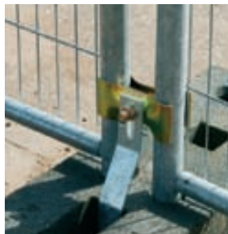
System zabezpieczający przed kradzieżą
