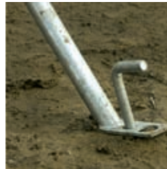
Przykładowe kotwienie wspornika
